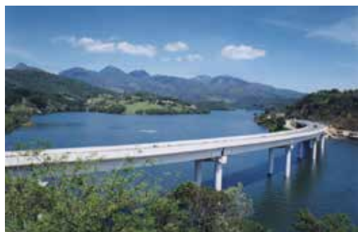
Represa do Capivari - Ponte Nova
