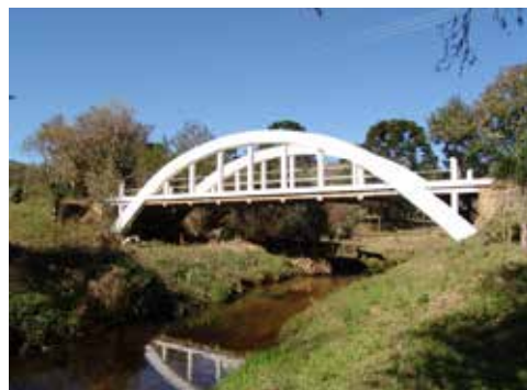
Ponte do Arco
