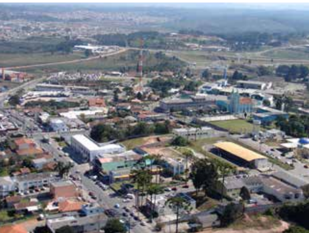
Quatro Barras - Vista Aérea
