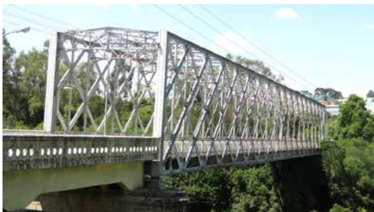
Ponte Metálica Dr. Diniz Assis Henning
