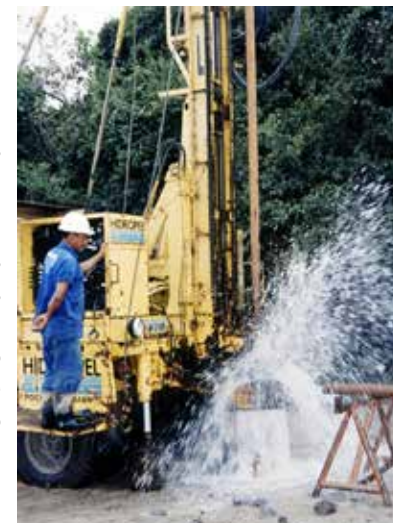
Obras de saneamento
