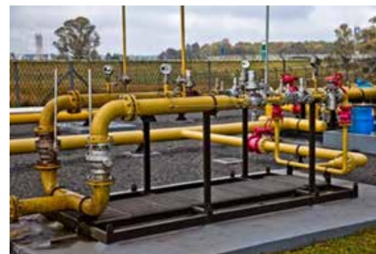
Canalização do Gás Natural
