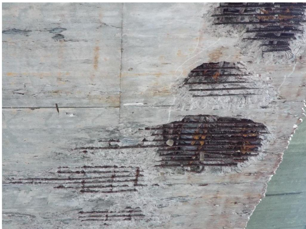
Detalhe da falha de concretagem e deslocamento de concreto na laje inferior.
