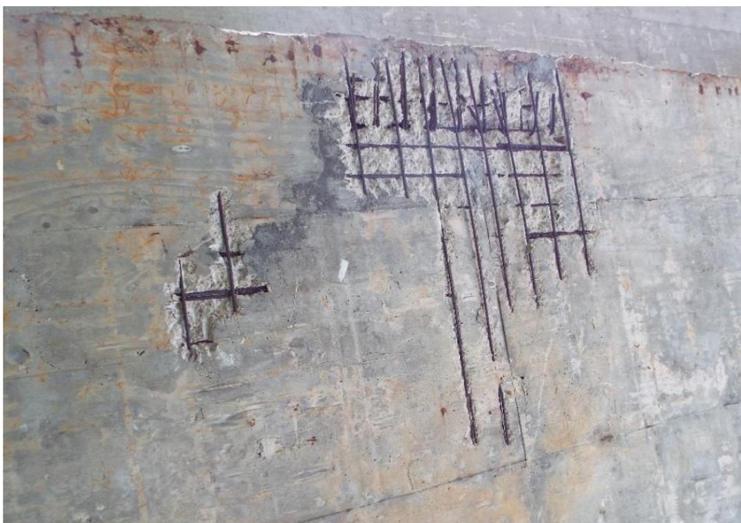
Detalhe do deslocamento de concreto na laje inferior.
