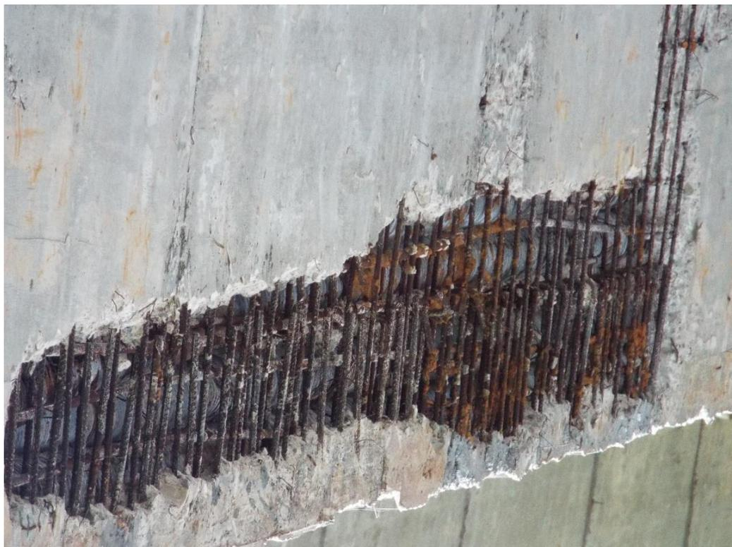
Detalhe da falha de concretagem na laje inferior.
