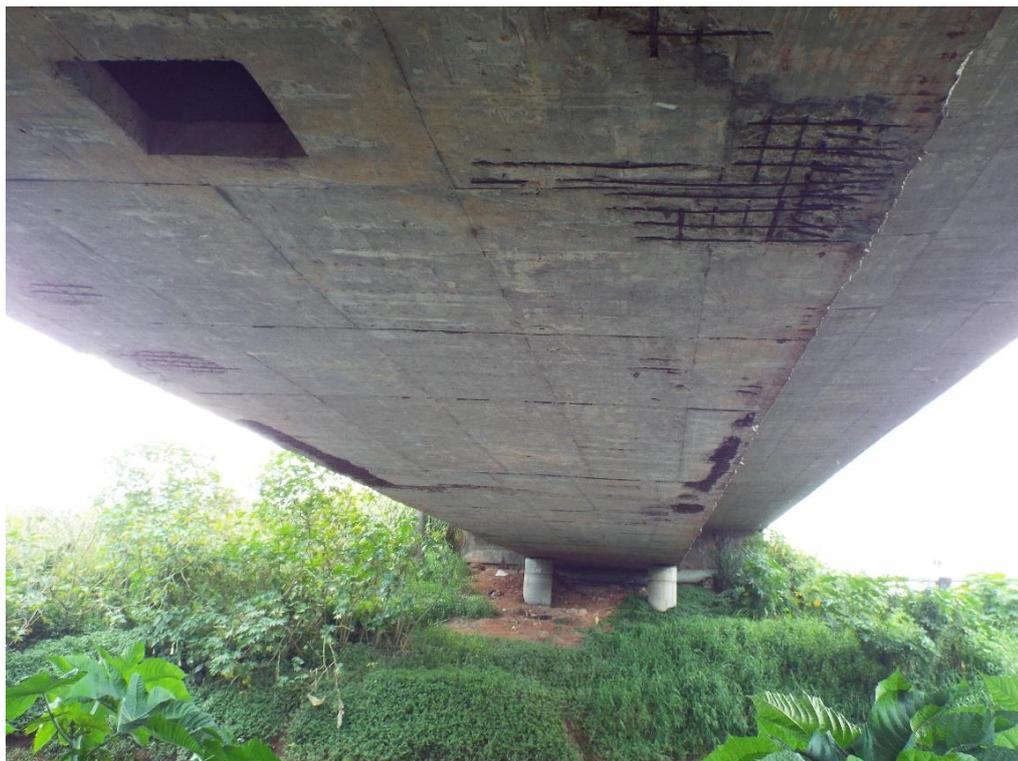
Face inferior da viga caixão – falhas de concretagem na laje inferior.
