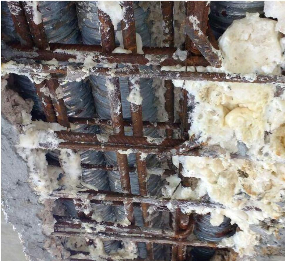
Detalhe da falha na concretagem – Mau posicionamento das bainhas impediu a passagem do concreto.
