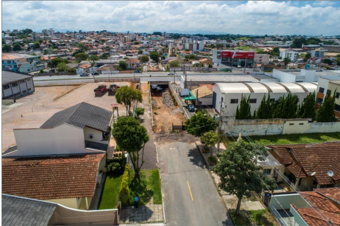
Visão geral da Trincheira da Rua Arapongas
