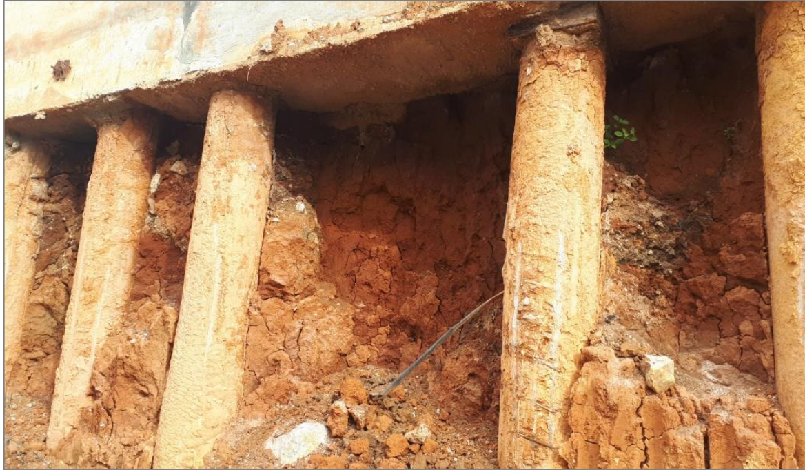
Detalhe das estacas das Cortinas de Contenção
