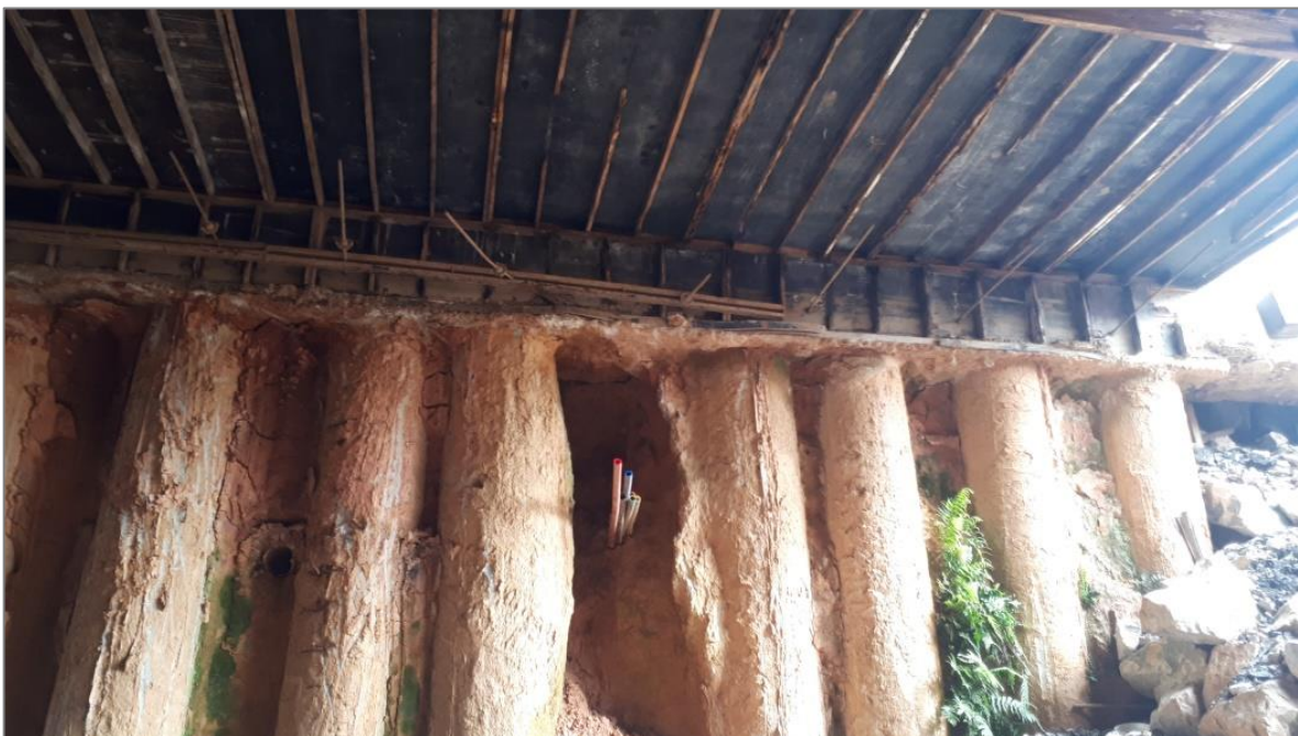
Detalhe das estacas das estacas das Cortinas de Contenção
