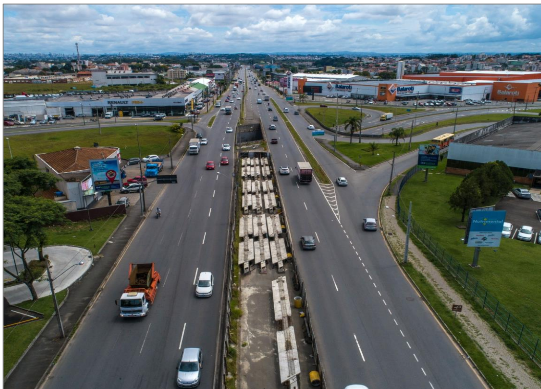
Visão geral do vão central da Trincheira da Av. Rui Barbosa
