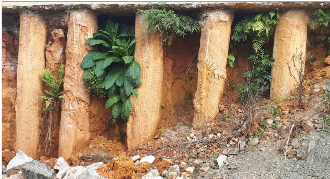
Detalhe das estacas das Cortinas de Contenção
