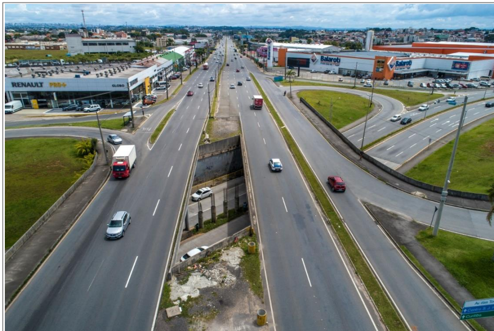
Visão geral do vão central da Trincheira da Av. Rui Barbosa
