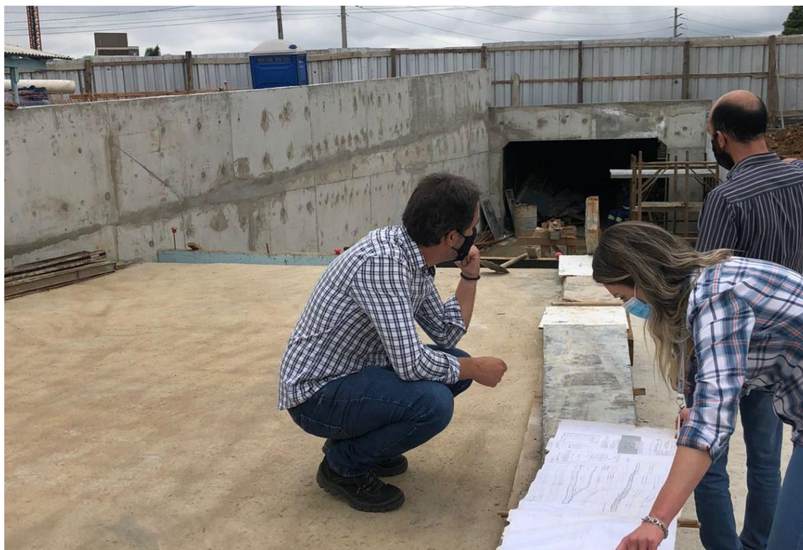
Figura 15 - Técnicos da Comec acompanham a realização das obras
