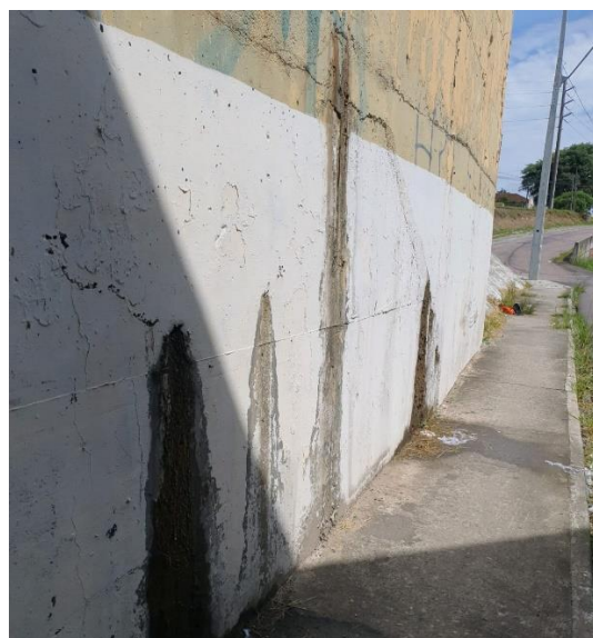
Figura 6 – Infiltrações na parede em concreto
