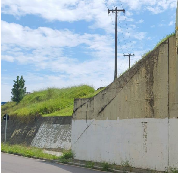
Figura 7 – Área com desagregação de parte da parede em concreto com exposição das armaduras
