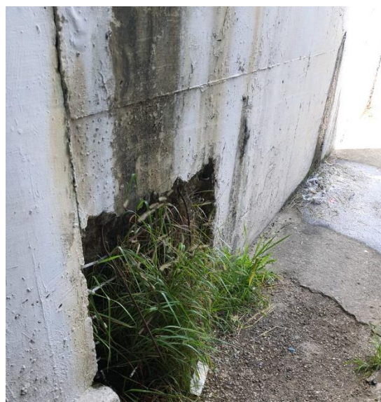
Figura 5 – Área com desagregação de parte da parede em concreto com exposição das armaduras
