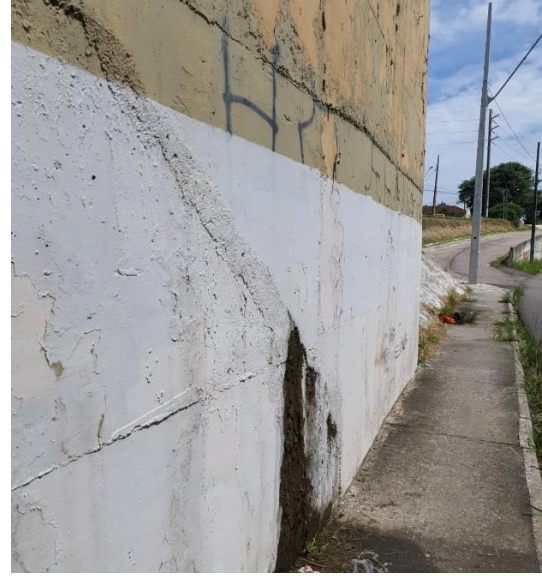
Figura 8 – Infiltrações na parede em concreto
