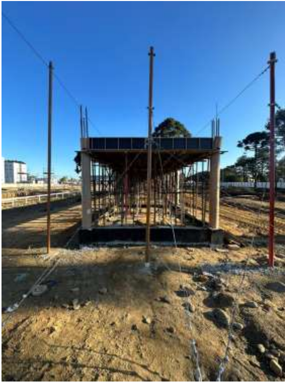
Figura 12 – Terminal São José dos Pinhais – Obras em andamento
