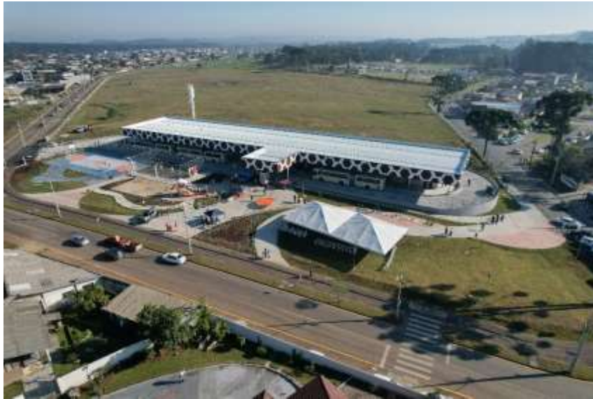
Figura 5 – Terminal Piraquara – Obra concluída
