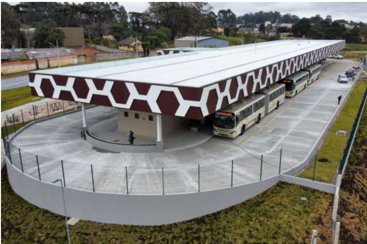
Figura 6 – Terminal Piraquara – Obras em andamento
