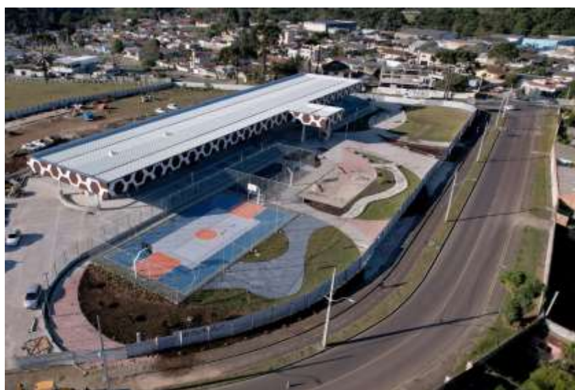
Figura 4 – Terminal Piraquara – Obra concluída
