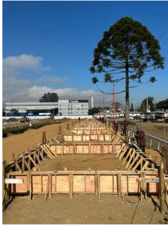
Figura 10 – Terminal São José dos Pinhais – Obras em andamento
