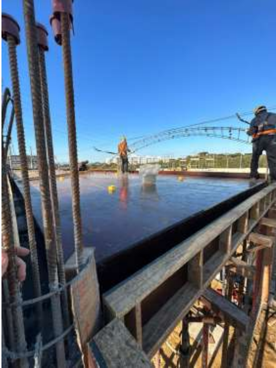
Figura 11 – Terminal São José dos Pinhais – Obras em andamento
