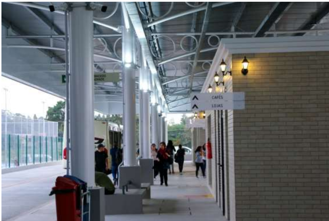
Figura 7 – Terminal Piraquara – Obras em andamento
