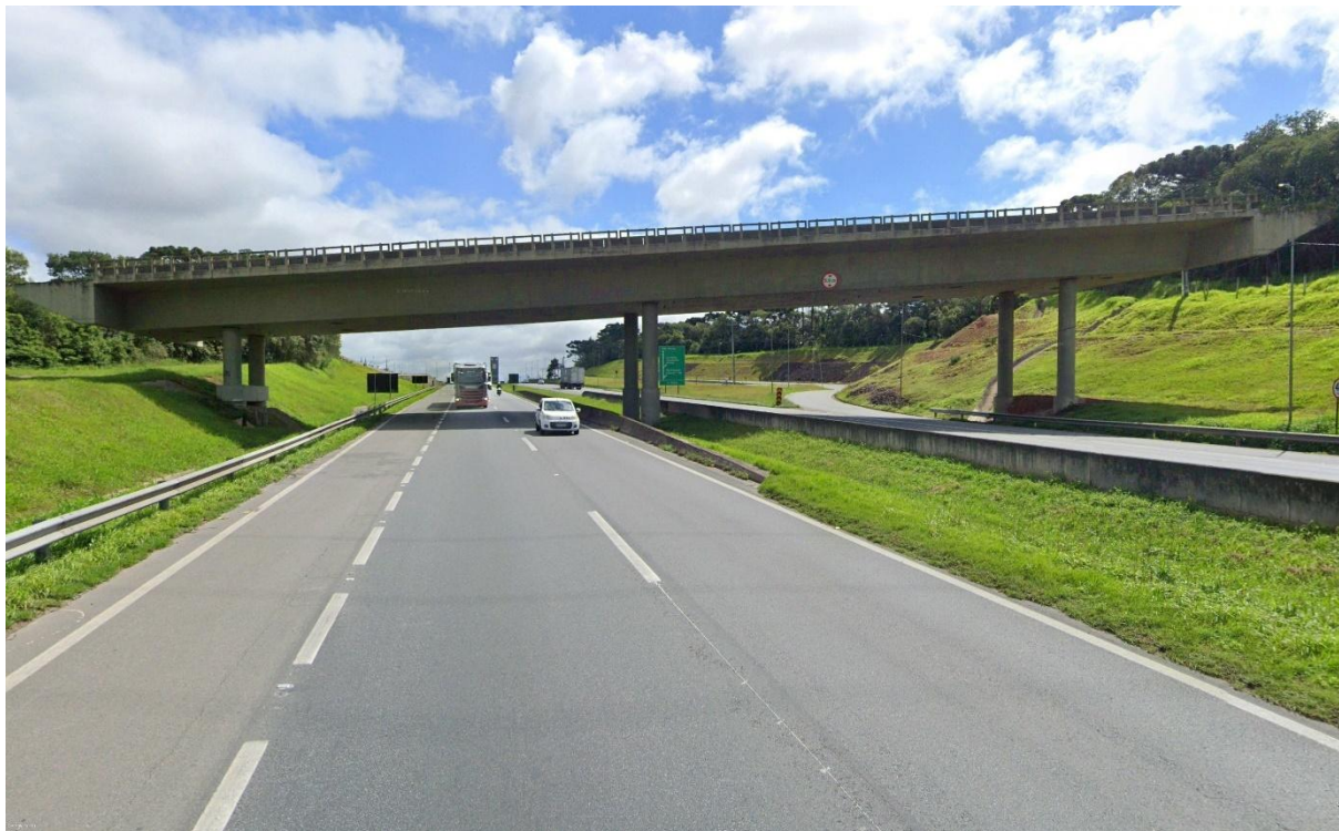
Figura 5 - Vista frontal viaduto (oeste)
