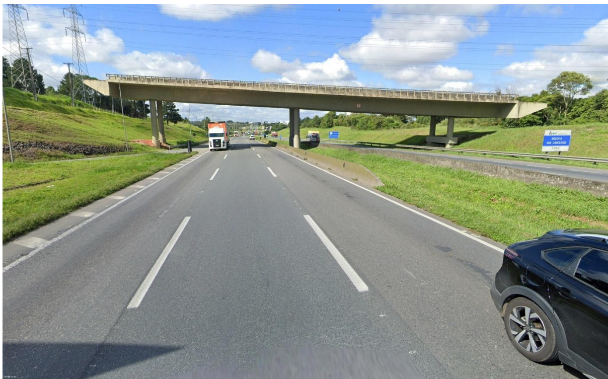
Figura 3 - Vista frontal viaduto (leste)
