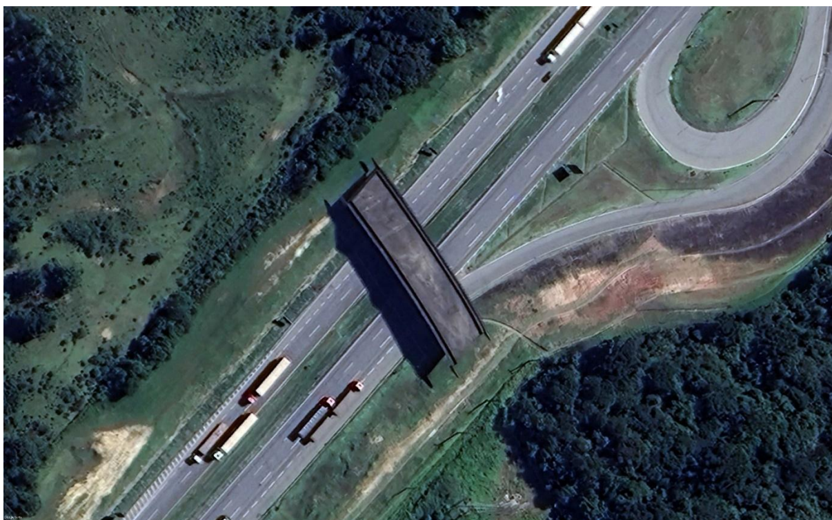
Figura 2 - Fotografia aérea viaduto
