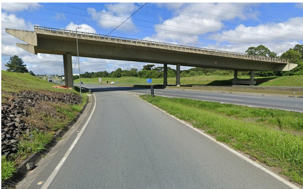
Figura 4 - Vista frontal viaduto (leste)
