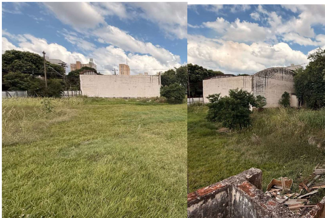
Figura 5 - Armazém a ser demolido, com cobertura demolida. Fonte: AMEP, 2025
