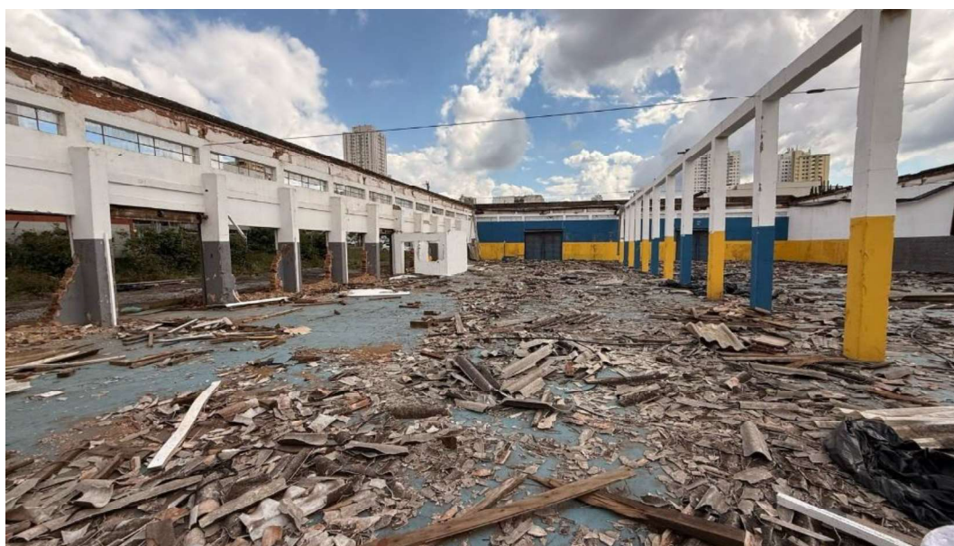
Figura 6 - Galpão parcialmente demolido. Fonte: AMEP, 2025.
