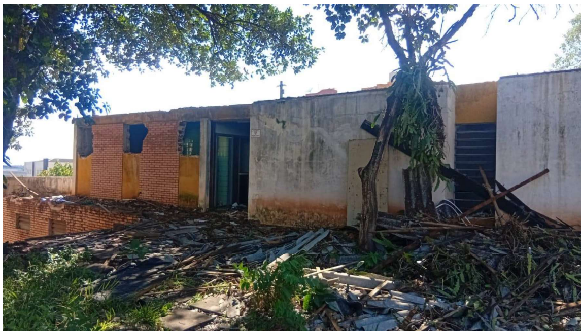
Figura 4 - Escritório parcialmente demolido. Fonte: AMEP, 2025.
