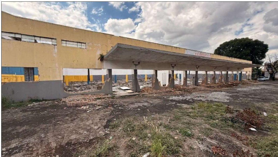
Figura 7 - Galpão parcialmente demolido. Fonte: AMEP, 2025.
