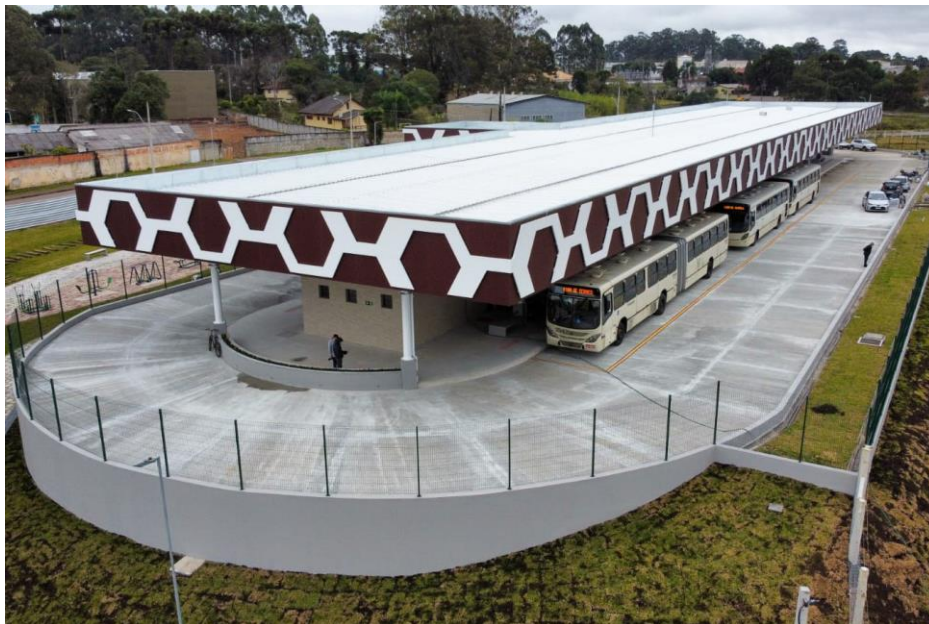
Figura 5 - Terminal Piraquara – Terminal em funcionamento
