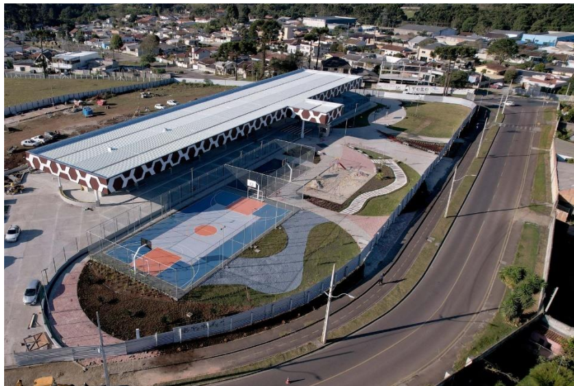
Figura 3 - Terminal Piraquara - Obra concluída
