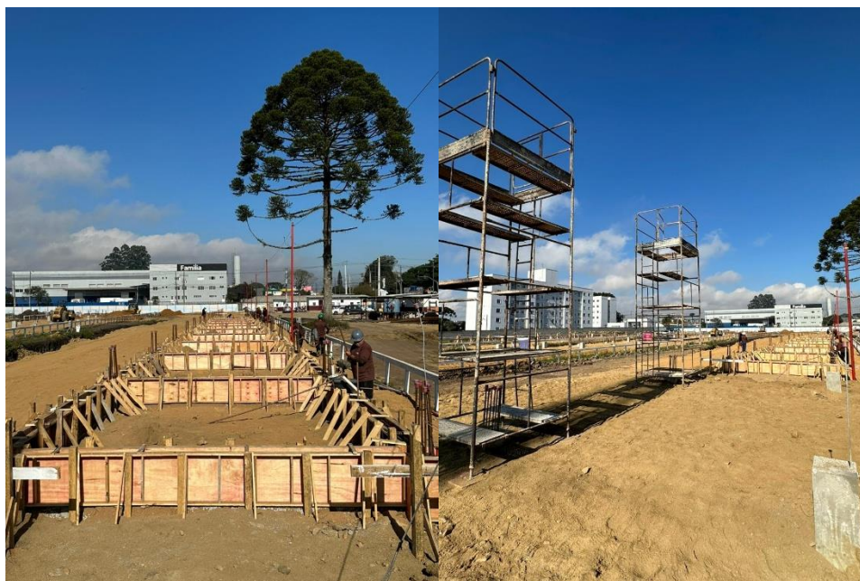
Figura 9 - Terminal São José dos Pinhais - Obras em andamento
