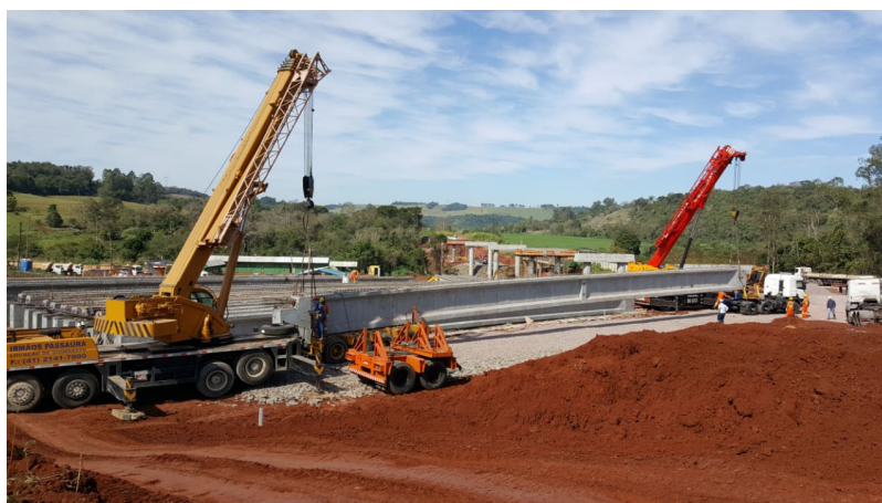
Figura 4 – Movimentação interna de vigas pré-moldadas em pátio, com utilização combinada de equipamentos auxiliares. Fonte: acervo técnico da Impugnante (imagem ilustrativa).
