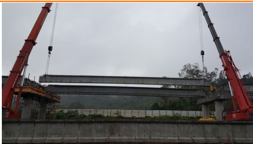
Figura 5 – Lançamento de vigas nos vãos, evidenciando operação combinada de transporte e içamento. Fonte: acervo técnico da Impugnante (imagem ilustrativa).
