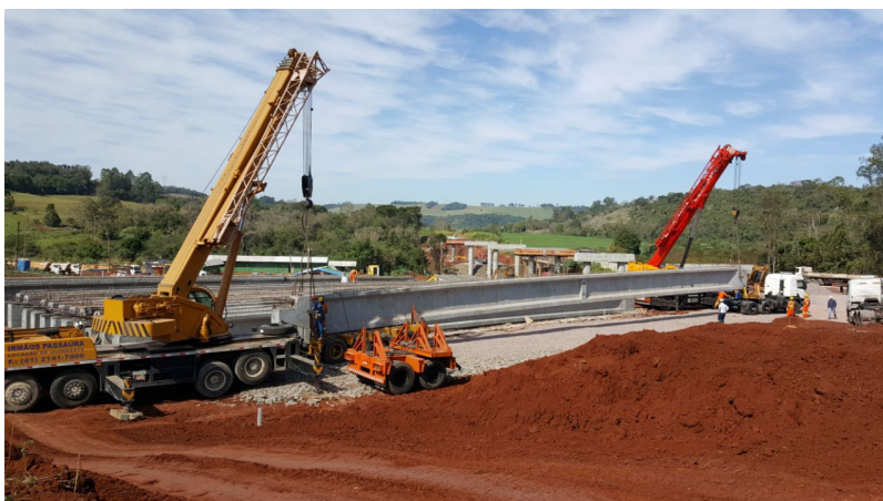
Figura 2 – Movimentação e carregamento de vigas sobre berços, evidenciando cargas concentradas e necessidade de solução estrutural. Fonte: acervo técnico da Impugnante (imagem ilustrativa).
